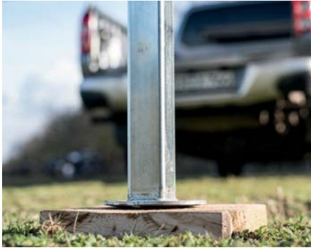
Auf losem Untergrund müssen Holzplatten unter die Stützen. Tipp für lange Lagerung: eine Plane ausbreiten gegen aufsteigende Feuchte
